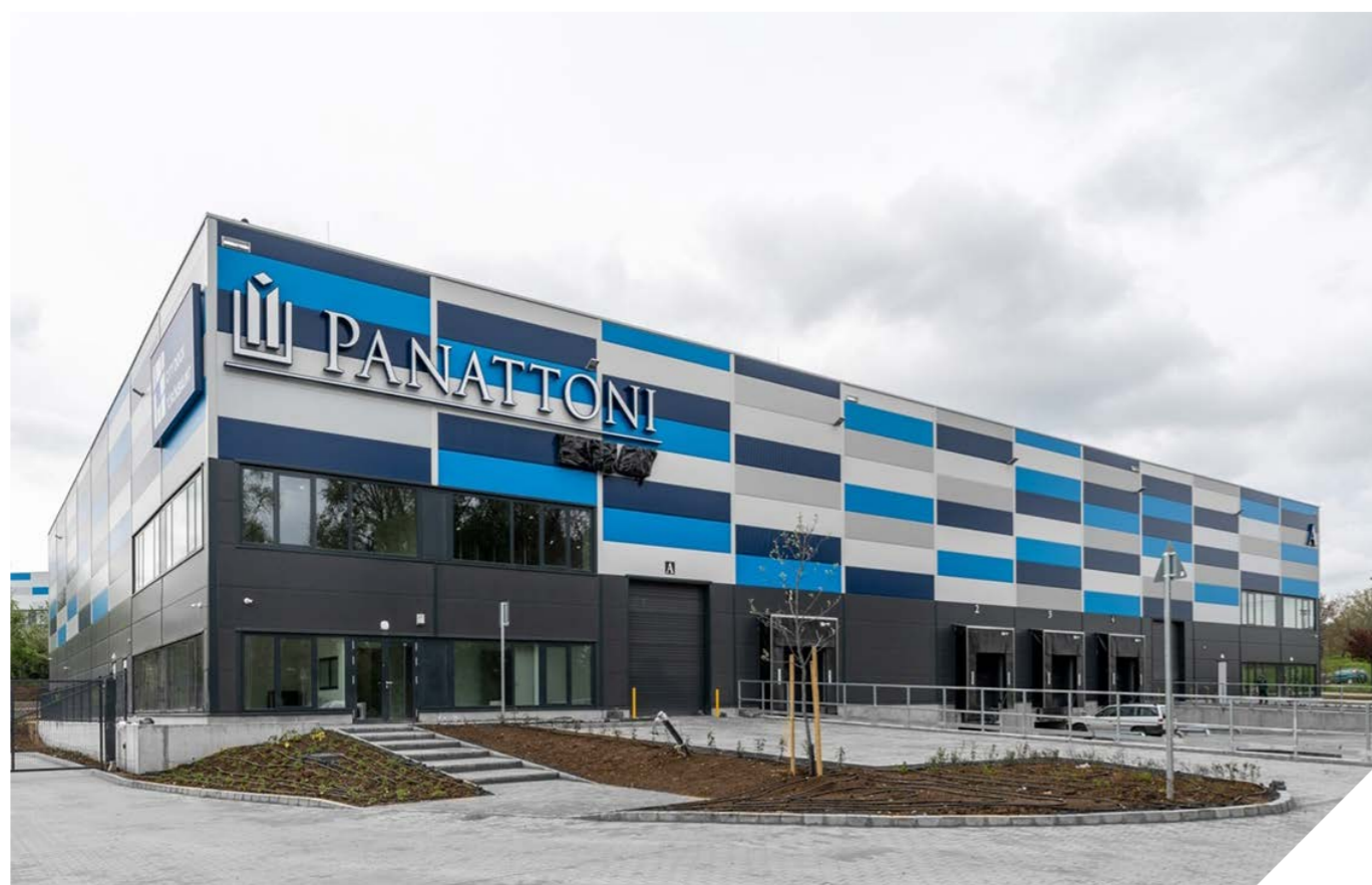
Panattoni City, Törökbálint Rok odovzdania: 2023 Dodané produkty: Kompletná prefabrikovaná konštrukcia Vyrobené množstvo: 2.130 m 3
