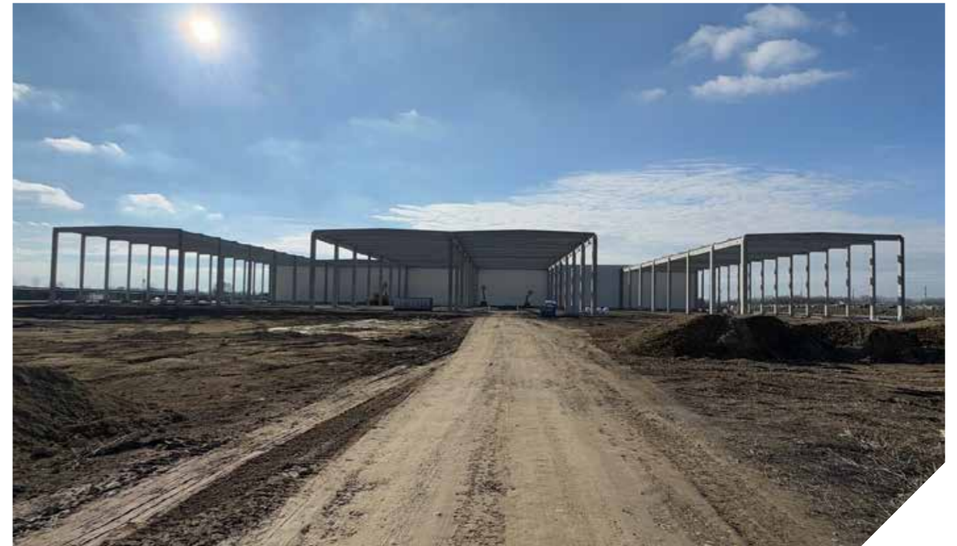
VGP Aerozone, Üllő Átadás éve: 2025. Szállított termékek: komplettelőregyártott szerkezet Alapterület: 12.163 m 2 Legyártott mennyiség: 1.235 m 3
